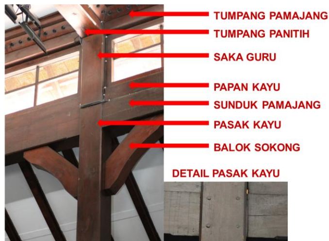
Gambar 5. Elemen Struktur Arsitektur Jawa pada Bangunan GKJW Pasamuwan Malang (Sumber: Pribadi, 2024)
