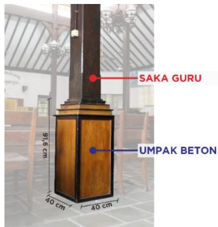
Gambar 3. Struktur Umpak Beton yang diletakkan di atas permukaan tanah (Sumber: Pribadi, 2024)
