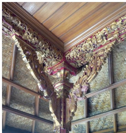
Gambar 5. Kencut dengan dimensi penampang saka terkecil 2 x 2 cm 2 yang diletakkan pada kepala saka sekeliling bale serta canggahwang dengan ukiran tembus yang memutus jalur gaya. Sumber: Saraswati (2014), (2015), (2016), (2017-a), (2019)
