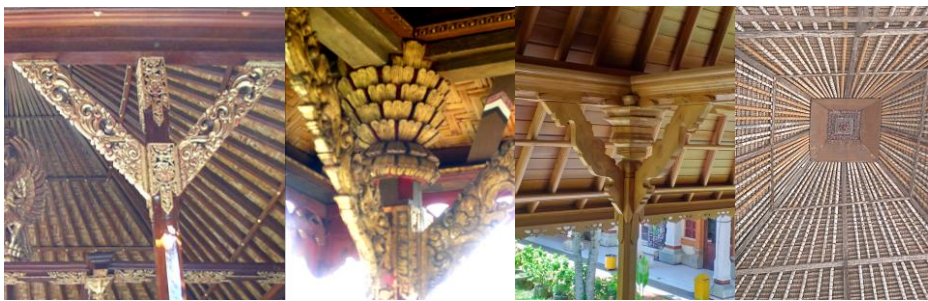
Gambar 3. Foto-foto canggahwang, kapu-kapu, bebakalan canggahwang dan kapu-kapu, petaka sebagai alat bantu pelatihan.
