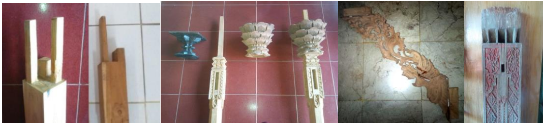
Gambar 2. saka pinggir pojok, saka pinggir tengah (kiri), saka tengah dengan kepala saka berupa kencut, saka pinggir dengan kepala saka berupa kapu-kapu (tengah kiri), canggahwang yang penuh ukiran yang perlu diperbaiki (tengah kanan), dedeleg (kanan).
