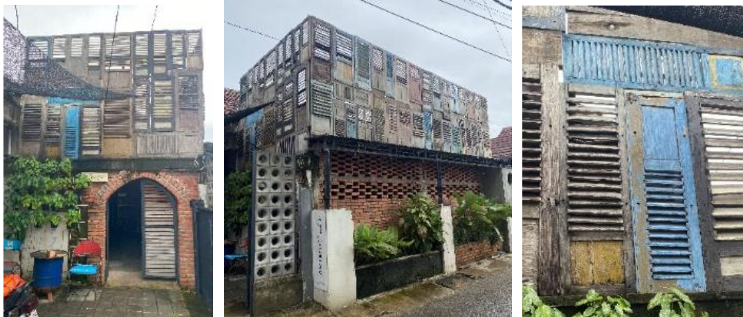
Gambar 7. Penerapan reuse material bekas pada fasad.
