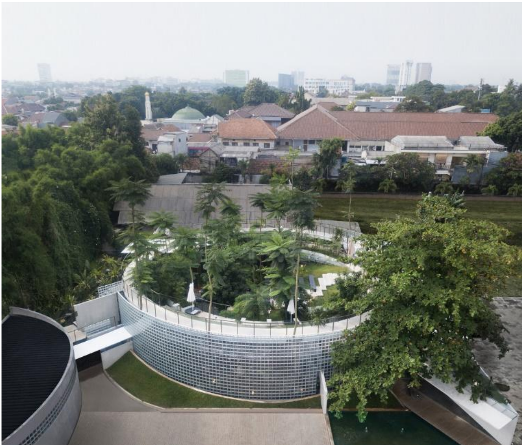
Gambar 1. Unsur tektonika berdasarkan material dan bentuk sebagai identitas bangunan Sumber: Abdel, 2021
