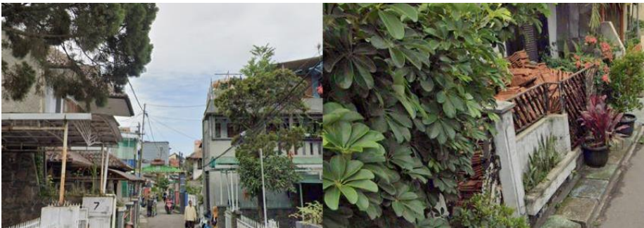
Gambar 3. Kondisi Jalan dan Drainase Sumber: Dokumentasi penulis, 2024
