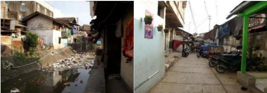
Gambar 1. Kondisi perumahan kumuh di Nyengseret Sumber: Observasi lapangan, 2024
