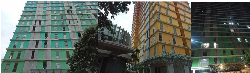
Gambar 8. Penampilan Fasad Pada Jam 10.00 Pagi, 14.00 Siang dan 18.00 Malam (Dari Kiri) Sumber: Survey Lapangan (2021)
