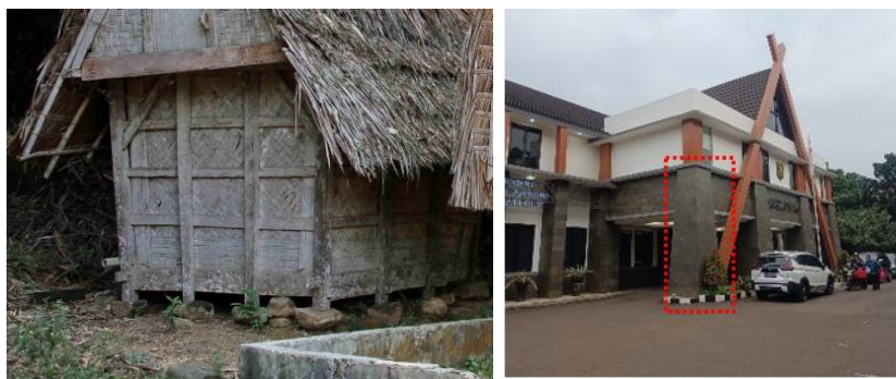
Gambar 9. Bangunan Leuit dan Bangunan bappedalitbang Bogor (Sumber : Fatahilaharis.wordpress, 2018) dan dokumen pribadi, 2022)
