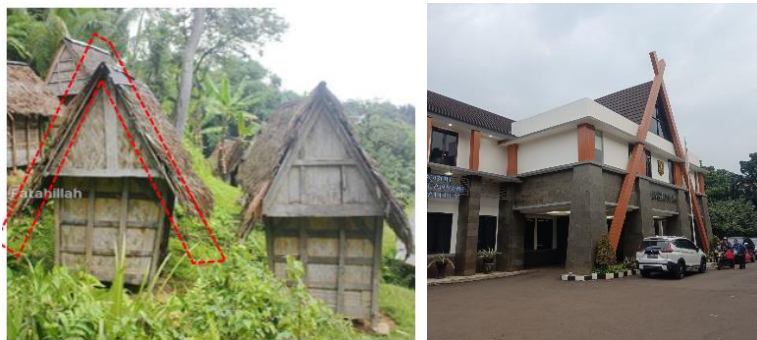
Gambar 7. Bangunan Leuit dan Bangunan bappedalitbang Bogor (Sumber : Fatahilaharis.wordpress, 2018 dan dokumen pribadi, 2022)
