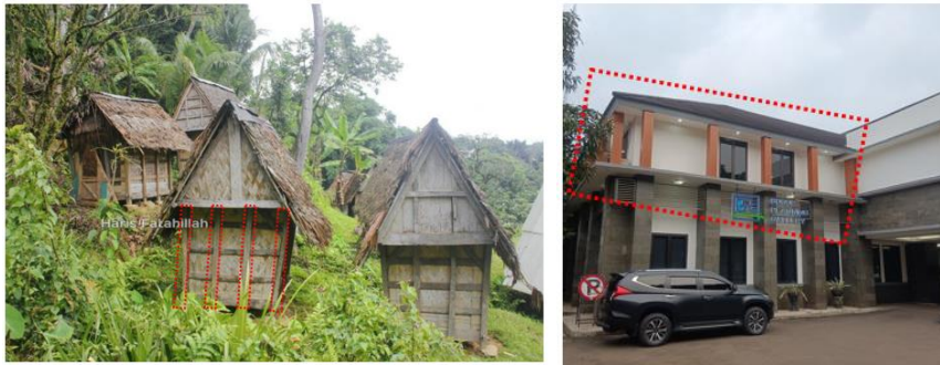
Gambar 8. Bangunan Leuit dan Bangunan bappedalitbang Bogor (Sumber : Fatahilaharis.wordpress, 2018) dan dokumen pribadi, 2022)
