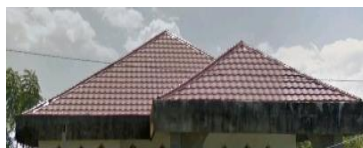
Gambar 14. Atap perisai pada sampel 8
