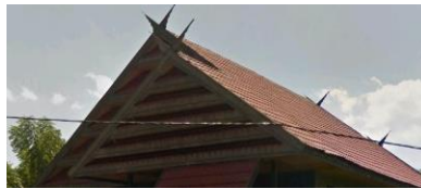
Gambar 13. Atap pelana pada sampel 1
