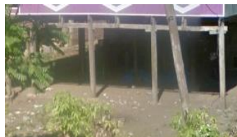
Gambar 21. Sampel 3 sebagai rumah berkolong / rumah panggung Sumber: Google Maps
