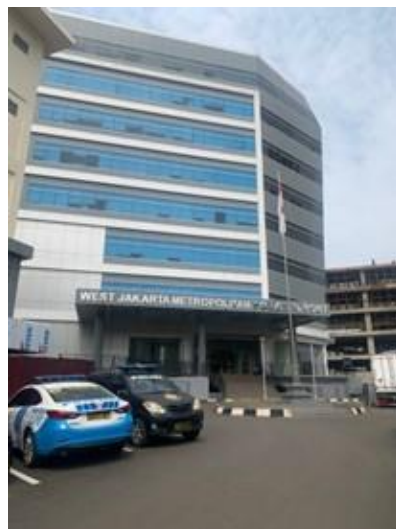
Gambar 2. Tampak Samping, Dokumentasi Lapangan 2022
