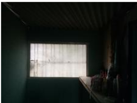
Gambar 8. Jendela di Tangga Sumber : Dokumentasi Pribadi, 2021
