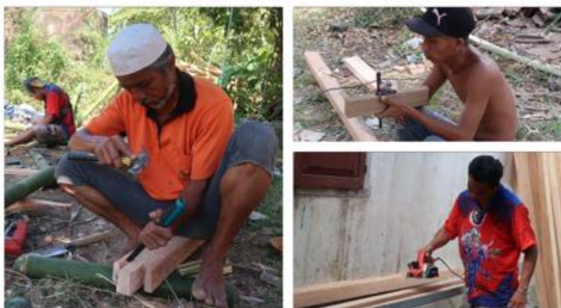
Gambar 7. Tukang Bambu Yang Terlibat dalam Proses Pembangunan Bebao House (Sumber: Octavia, 2019)
