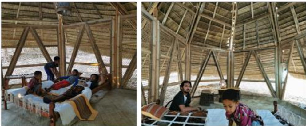
Gambar 15. Interior Bebao House dalam Keadaan Komponen Dinding "Terbuka" (Sumber: Octavia, 2019)
