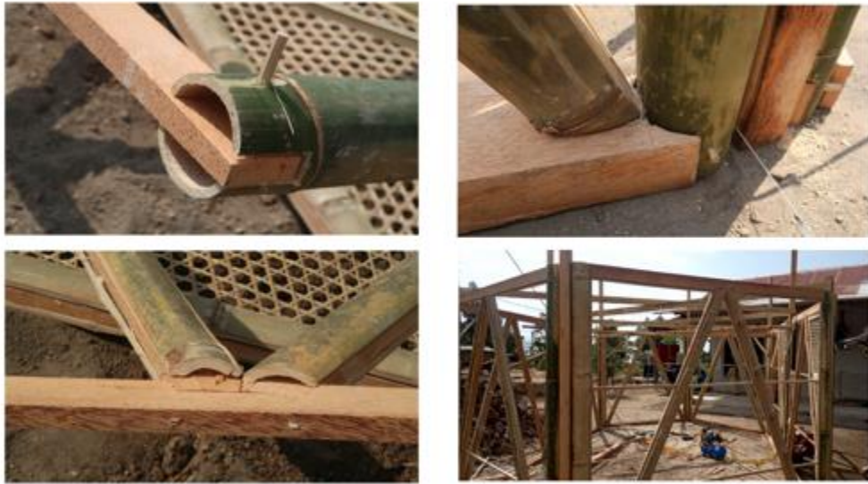
Gambar 12. Detail Sambungan untuk Menyatukan Kayu dan Bambu ( Sumber: Octavia, 2019 )
