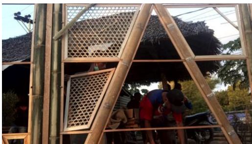
Gambar 8. Proses Pembuatan Dinding Pengisi yang Interchangeable (Sumber: Octavia, 2019)
