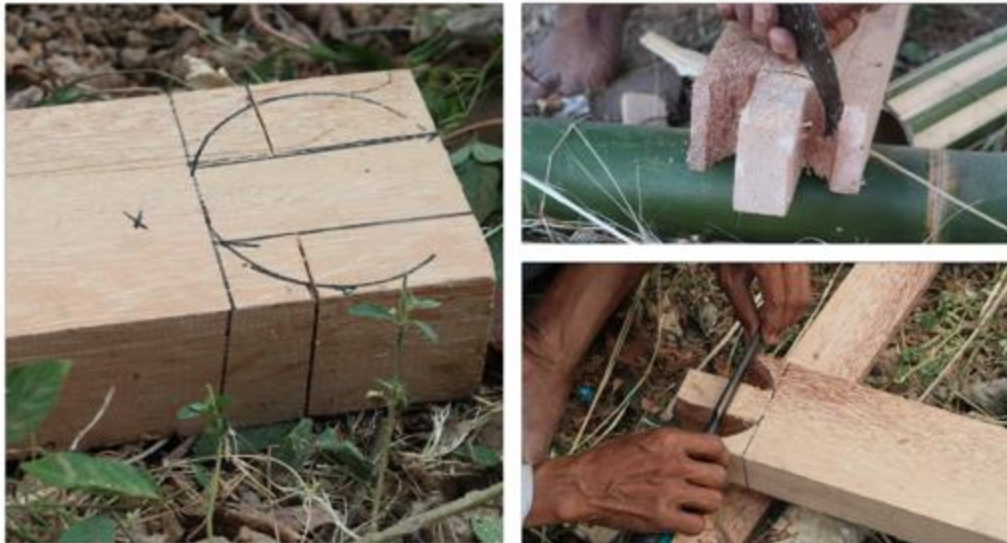
Gambar 10. Proses Melubangi Kayu untuk Balok dengan Cara yang Manual ( Sumber: Octavia, 2019 )
