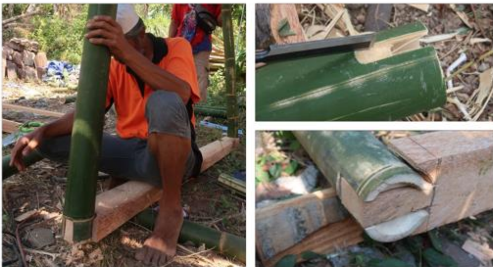
Gambar 11. Proses Memasang Bambu Pada Balok Kayu ( Sumber: Octavia, 2019 )
