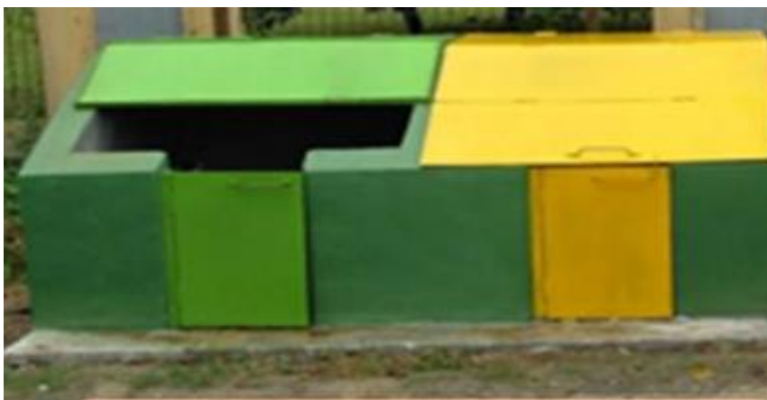
Gambar 1. Tempat Penampungan Limbah Konstruksi Sebelum Diangkut Keluar Site
