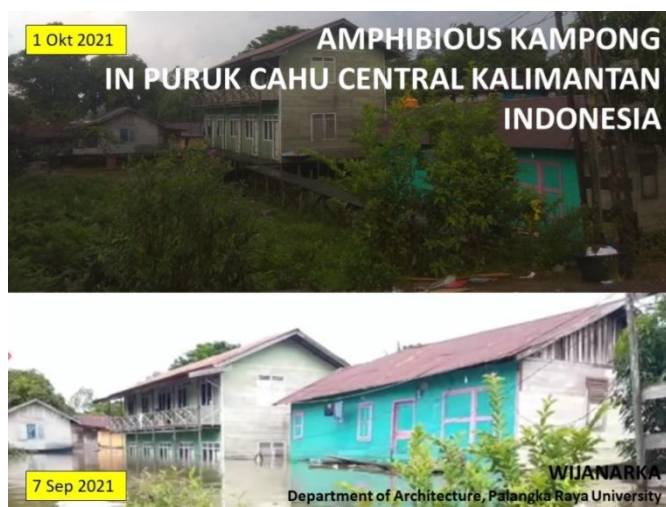
Gambar 8. Foto Rumah Amfibi Mengapung Saat Banjir Besar (Bawah) dan Saat Napak Ketika Tidak Banjir (Atas)
