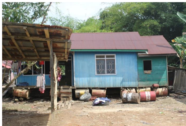
Gambar 6. Rumah yang Menggunakan Drum Besi Sebagai Fondasi
