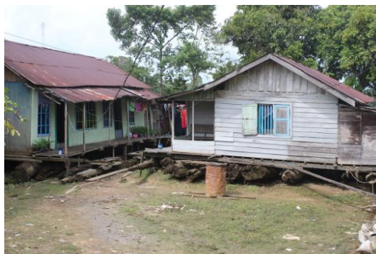
Gambar 4. Rumah yang Masih Mempertahankan Batang Kayu Sebagai Fondasi
