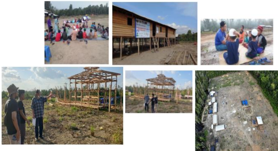
Gambar 6. Pembangunan Pondok Pesantren di Area Dusun dan Bangunan Menyerupai Kapal
