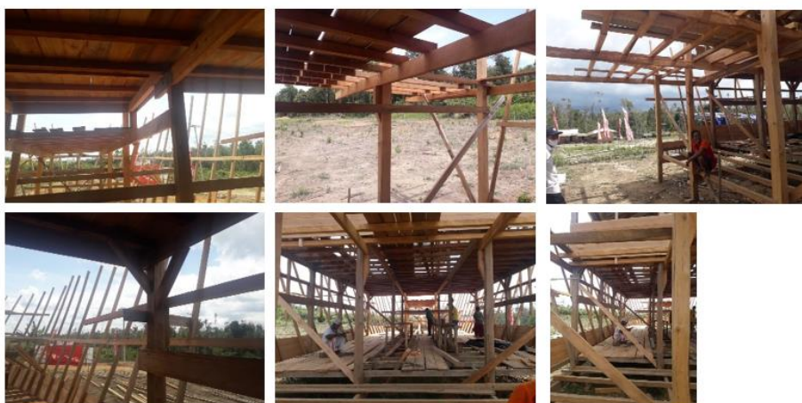
Gambar 7. Konstruksi Kayu Bangunan Menyerupai Kapal di Area Pondok Pesantren
