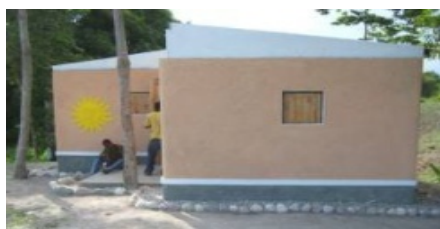
Gambar 11. Finishing earthbag building dengan cat dan mural Sumber: Patti Stouter, ASLA, 2008
