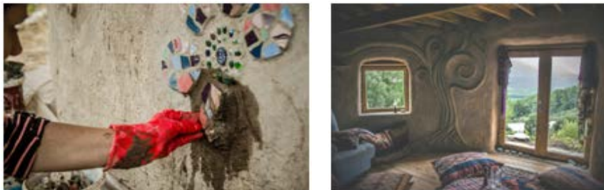
Gambar 14. Penerapan earth plaster pada eksterior dan interior earthbag building
