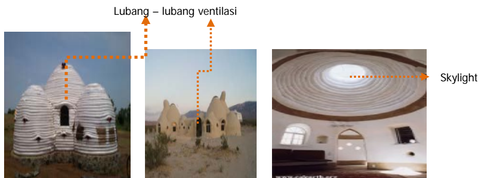
Gambar 13. Skylight dan lubang - lubang ventilasi bangunan earthbag
