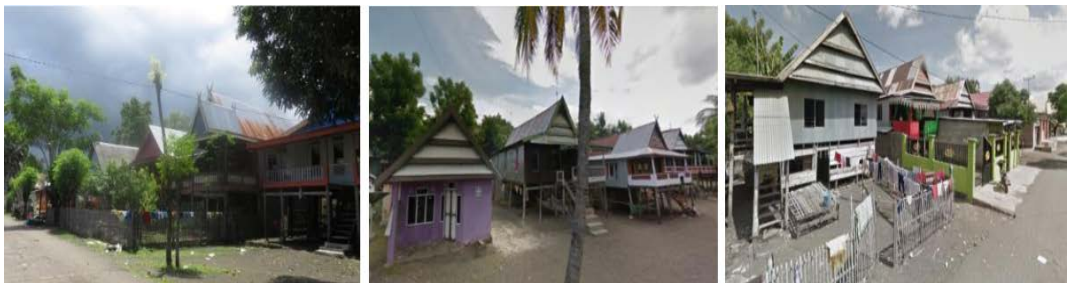
Gambar 3. Kondisi Permukiman Zona F dan E
