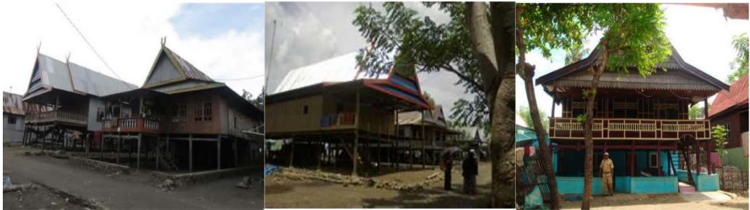
Gambar 2. Kondisi permukiman pada zona A
