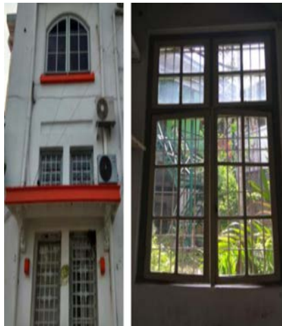
Gambar 8. Jenis jendela luar dengan jbenjukan persegi dengan jerjak besi dan jendela dalam bahan kaca bentuk persegi (sumber: Dokumentasi pribadi, 2019)
