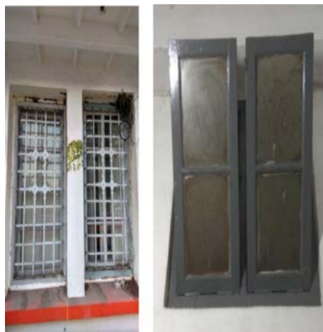
Gambar 7. Jenis jendela luar dengan jerjak besi dan jendela bagian dalam Sumber: Dokumentasi pribadi, 2019
