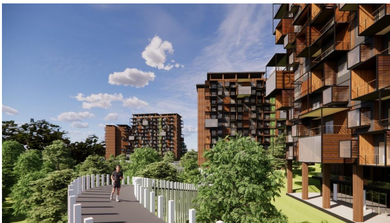
Gambar 10. Aerial tampak Komplek Rumah Susun ASN 3 di IKN. Sumber: Diolah oleh Penulis, 2025
