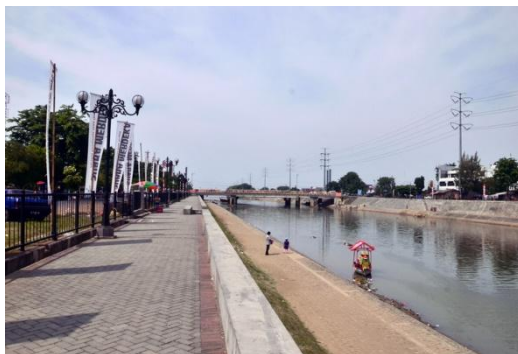
Gambar 11. Seting Sungai Banjir Kanal Barat yang leluasa
