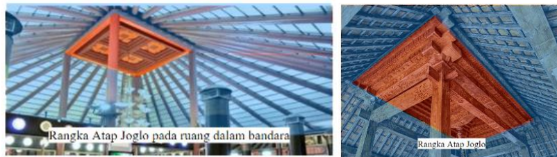
Gambar 1. Rangka atap joglo pada elemen bangunan dan ornamen pada kolom Terminal CGK
