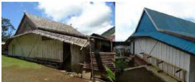
Gambar 9. Folajiko Sorabi dengan material atap daun sagu seluruhnya (kiri) dan material atap perpaduan daun sagu-seng (kanan) Sumber: Dokumentasi penulis, 2024
