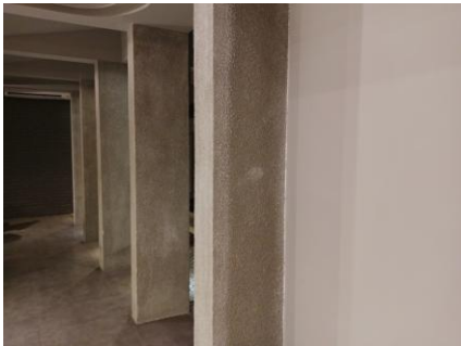
Gambar 4. Material bangunan Brewing Room Cafe Sumber: Dokumentasi penulis, 2024
