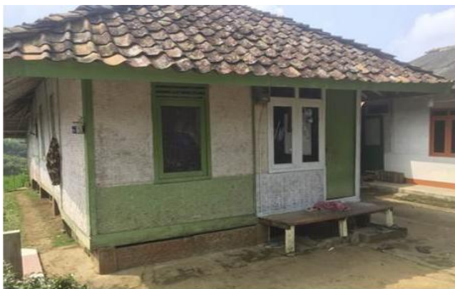
Gambar 6. Bangunan yang sudah diangkat dan diletakkan kembali di atas umpak
